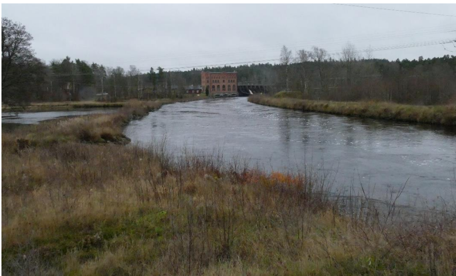
Figur 3-27. Knäredkanalen fotograferad i uppströms riktning. Kraftstationen för Knäred Övre syns i mitten av bilden. (Foto: Sweco, 2021)
