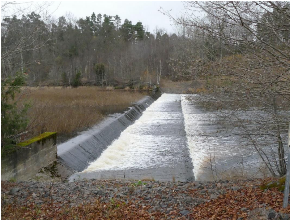
Figur 3-25. Övre grunddammen i naturfåran. För placering av grunddammen på karta, se Figur 5-6. (Foto: Sweco, 2021)
