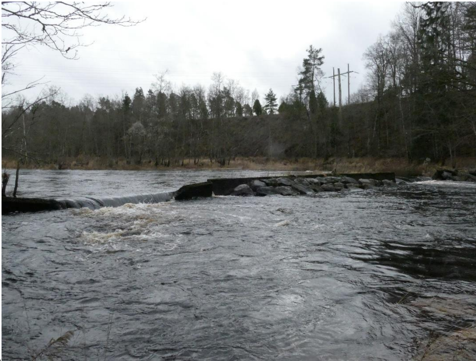
Figur 3-24. Nedre grunddammen i naturfåran. För placering av grunddammen på karta, se Figur 5-6. (Foto: Sweco, 2021)
