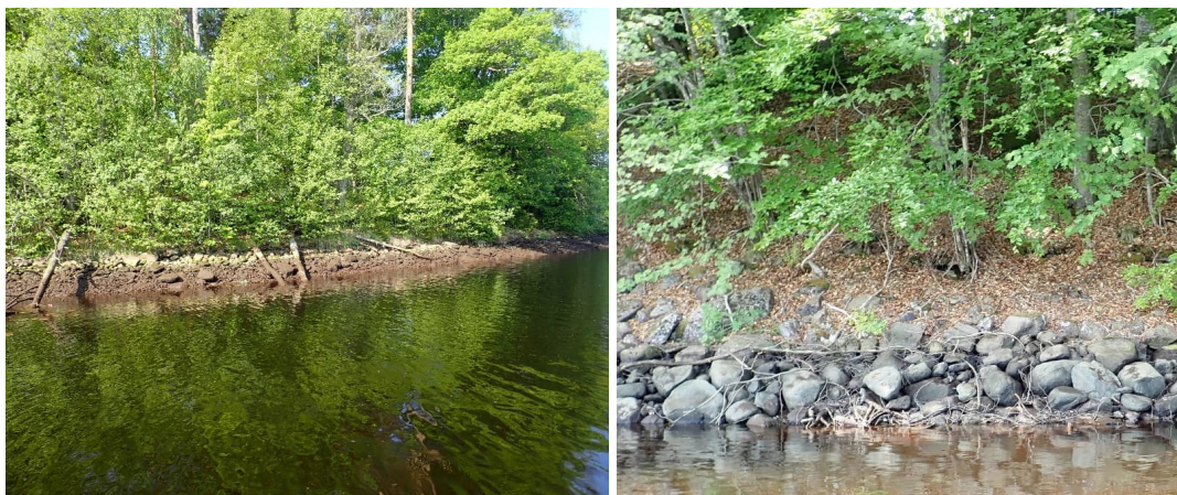
Figur 20 Foto över stenpåls längs strandlinjen med magasinets nivå +75,48 (södra delen av magasinet).
