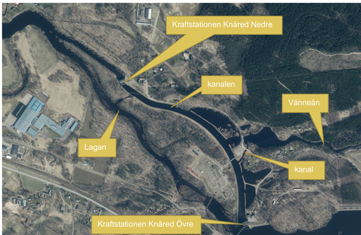
Figur 5 Anläggningen i Knäred Nedre, Lagan rinner åt vänster i bild (Foto från https://minkarta.lantmateriet.se/ ).
